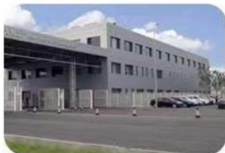
工場・物流倉庫
